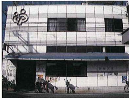
温浴施設外観写真
